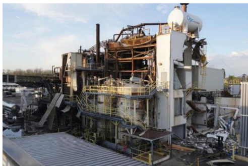
รูปที่ 1. ดักผลิตรезิ่นหลังจากเกิดระเบิดด้านใน (ที่มา: CSB report No.2021-04-I-OH)
